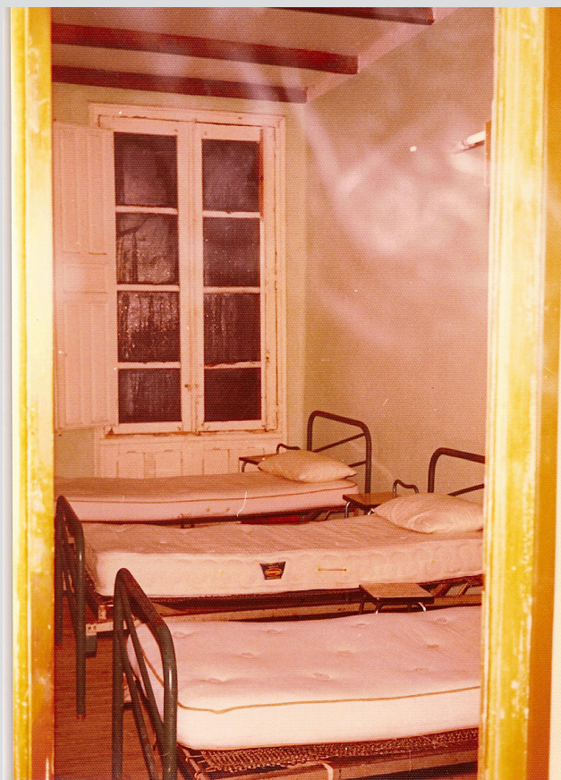
El techo de "poliespan"
